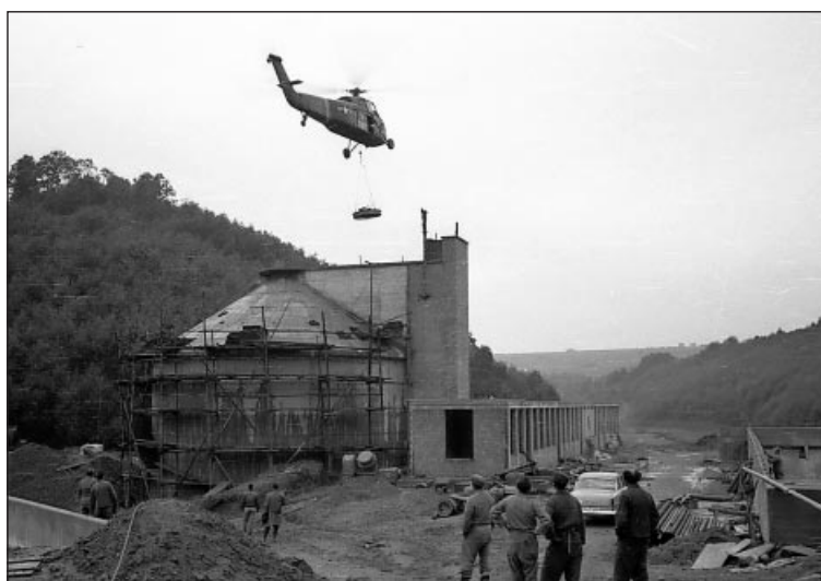
Beim Bau der Kläranlage kamen der Stadt die US-Streitkräfte zu Hilfe. Die schweren Teile des Faulbehälters wurden von US-Hubschraubern vor Ort gebracht und montiert. FOTO: STADTARCHIV
